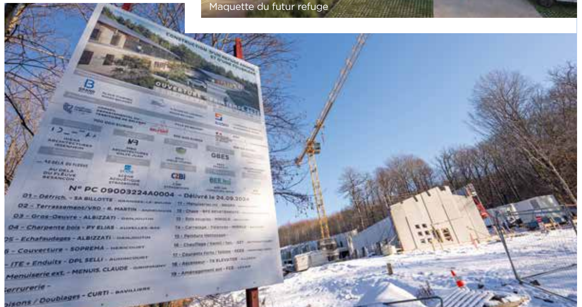
Le gros œuvre du nouveau refuge (bâtiment de 375 m 2 est en cours d'achèvement)
