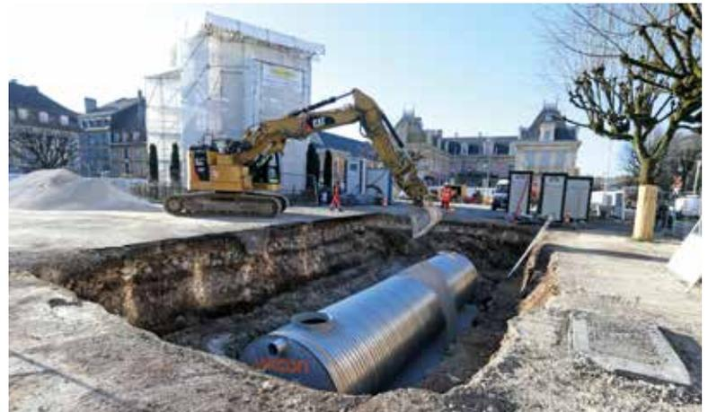
**D'impressionnantes cuves de récupération d'eau, d'une contenance totale de 170 m<sup>3</sup>, sont enfouies sous la nouvelle place de la République pour alimenter le miroir d'eau en circuit fermé.**
