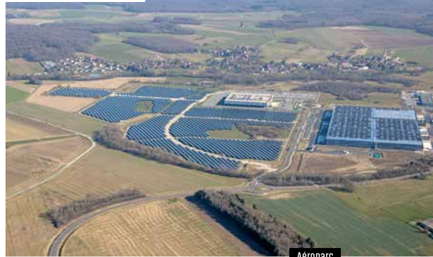
Aéroparc de Fontaine
