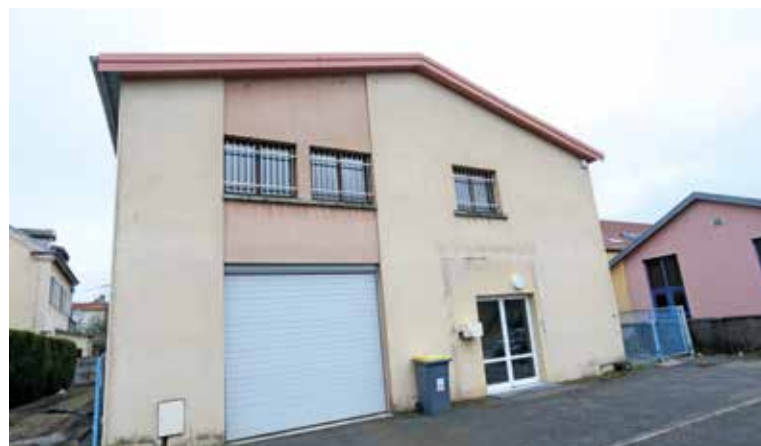
Les nouveaux locaux de la Protection civile rue Romain-Rolland
