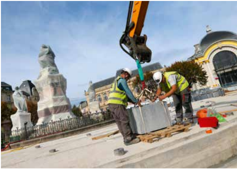
La pose des pierres de taille pour le futur miroir d'eau, un travail minutieux et précis
