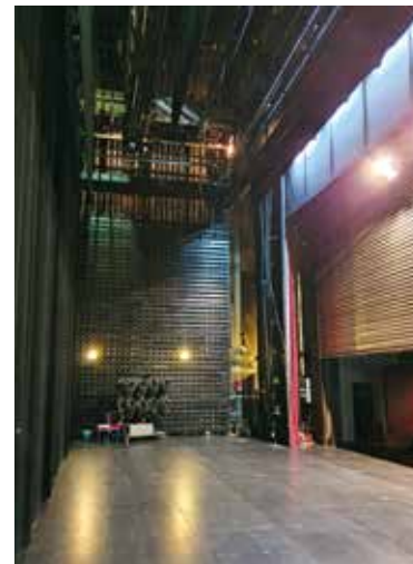
Les installations scéniques vont être remplacées et le rideau de fer (à droite) supprimé
