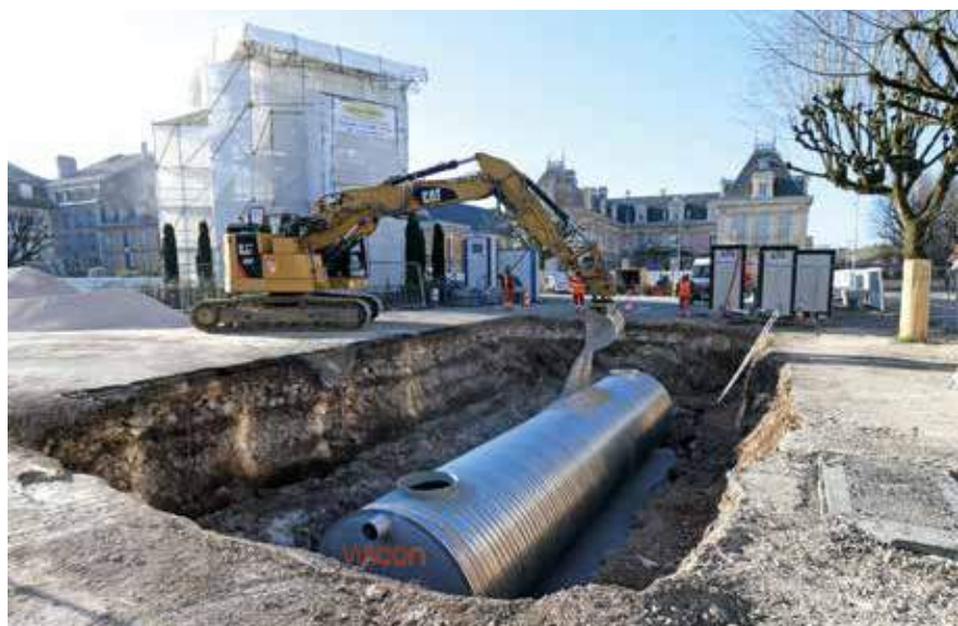
La pose de l'une des cuves de récupération des eaux de pluie des toitures, place de la République
