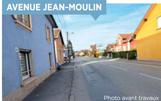
Photo avant travaux
