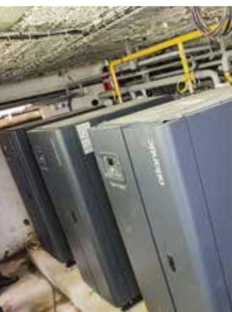
Au multi-accueil Voltaire, deux chaudières au gaz datant de 1991 ont été rénovées avec ajout de la condensation pour une meilleure efficacité énergétique. Elles ont été équipées d'une gestion technique centralisée permettant de suivre leur fonctionnement à distance et d'intervenir plus rapidement en cas de problème.
