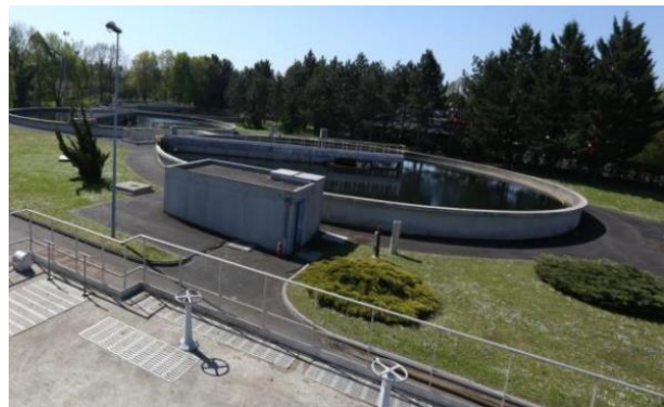
Clarificateurs de l'Unité de dépollution des eaux usées de Belfort
