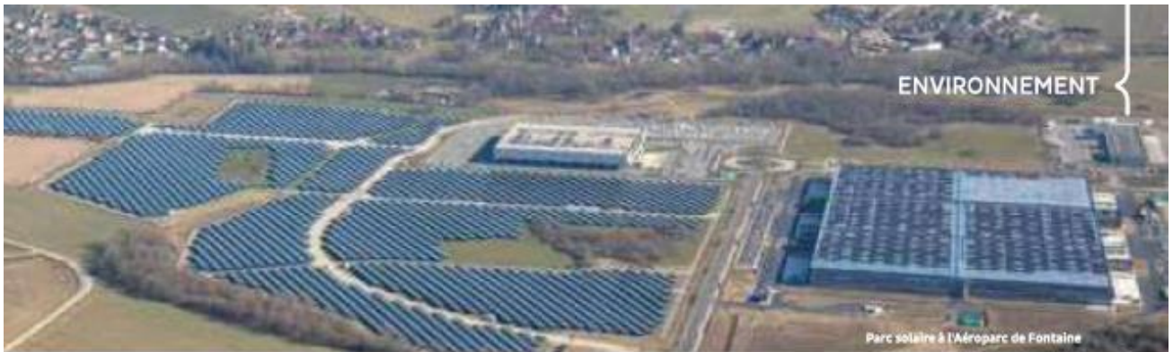
Parc solaire à l'Aéroparc de Fontaine
