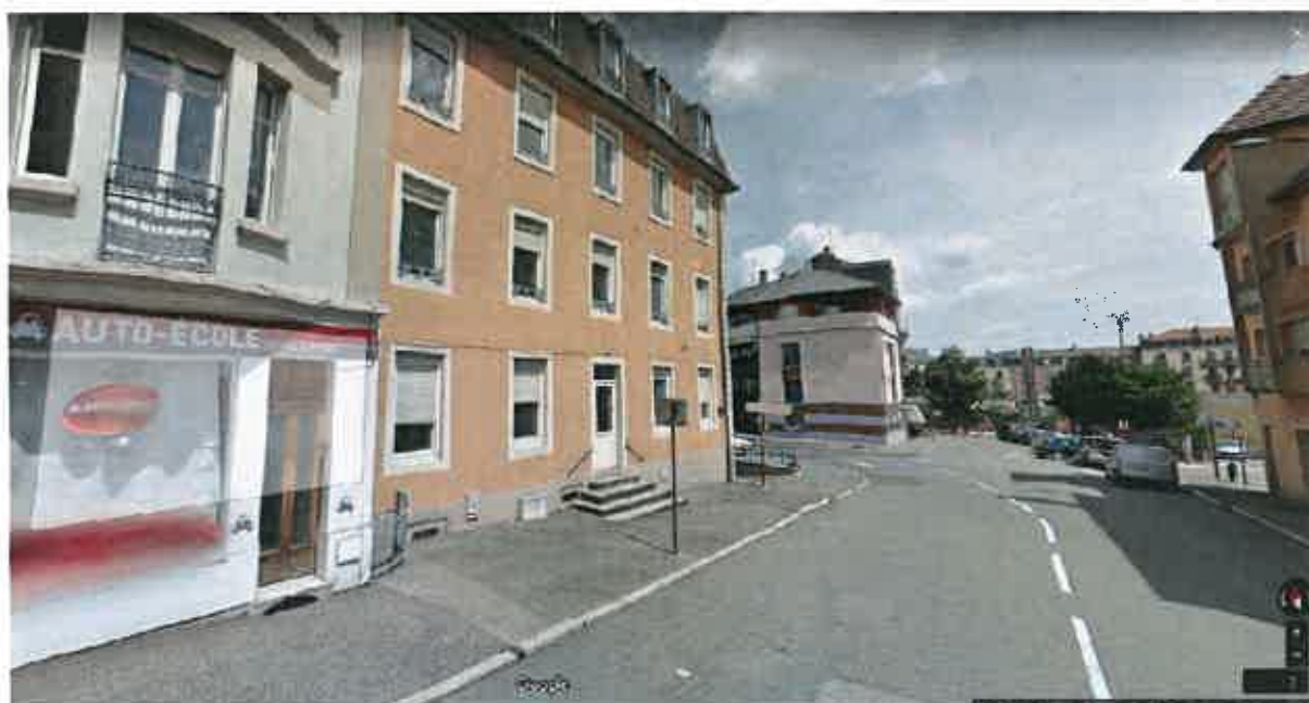
Aménagement au droit du 14 rue Roosevelt
