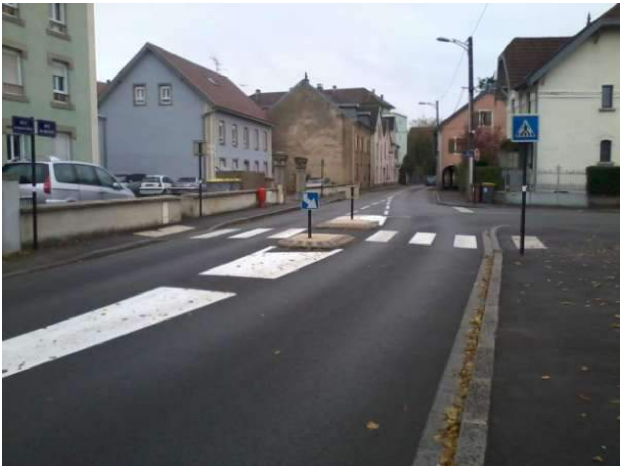
Travaux réalisés rue du magasin
