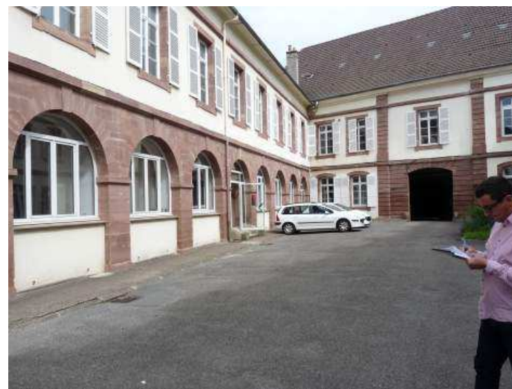
Cour intérieure bâtiment 005
