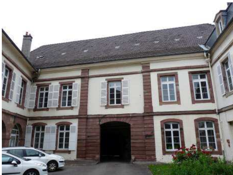
Cour intérieure bâtiment 004
