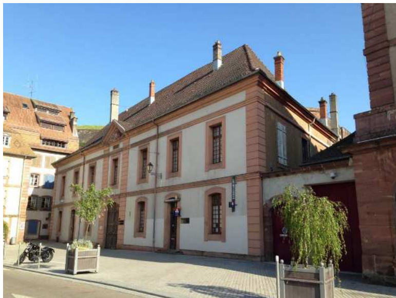
Place de l'Arsenal bâtiment 004
