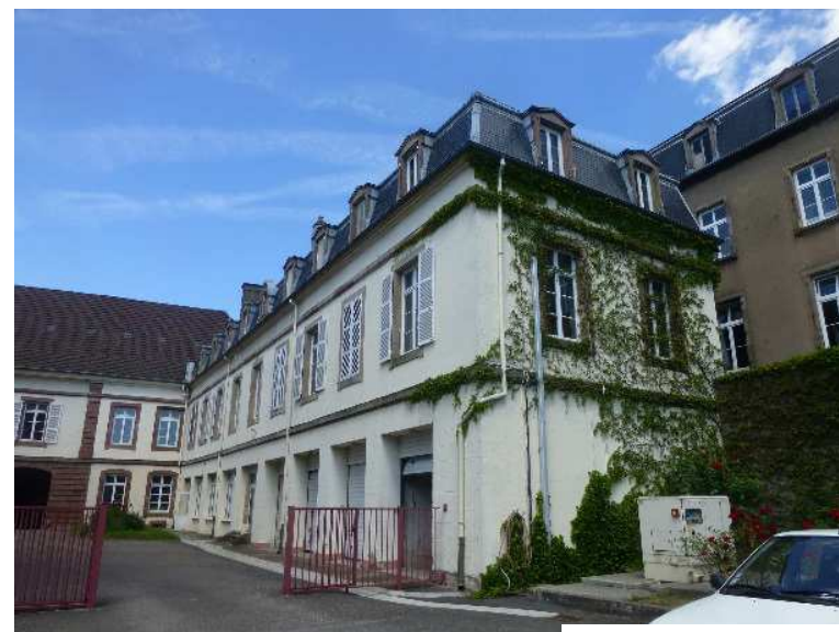
Cour intérieure bâtiment 005
