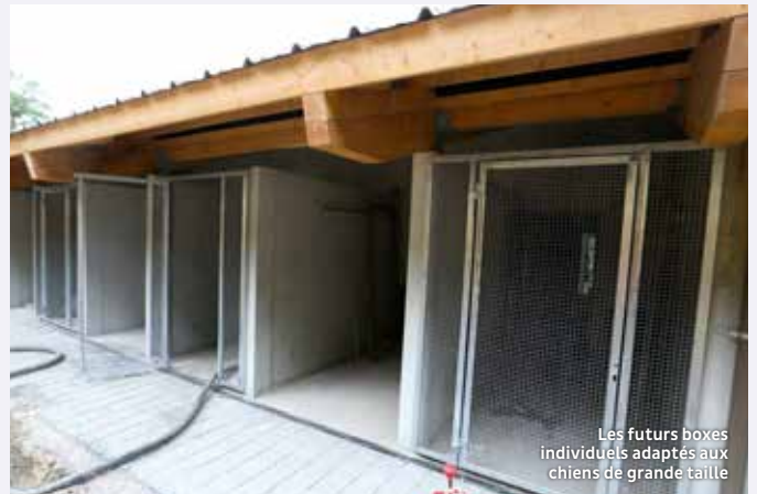
Le refuge en chantier
