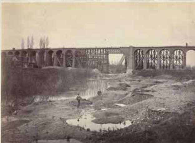
Le viaduc de Dannemarie, en reconstruction après avoir été dynamité en novembre 1870 pour ralentir la venue des troupes prussiennes à Belfort.
