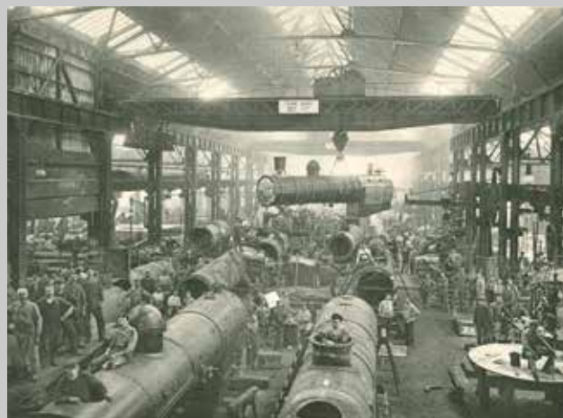
Atelier de chaudronnerie.
