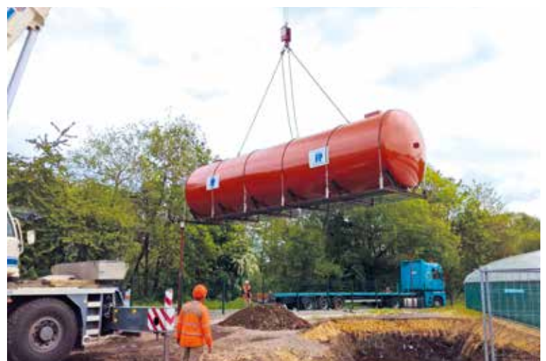
La cuve a été installée en mai.
