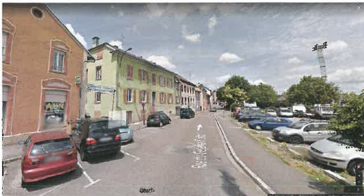
Aménagement au droit du 14 et 16 rue Foltz
