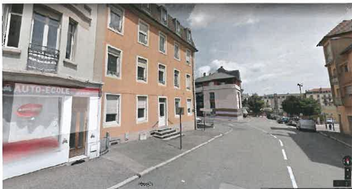
Aménagement au droit du 14 rue Roosevelt
