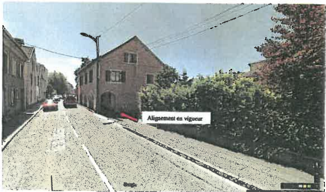
Réalisation de l'alignement 59 rue du Magasin
