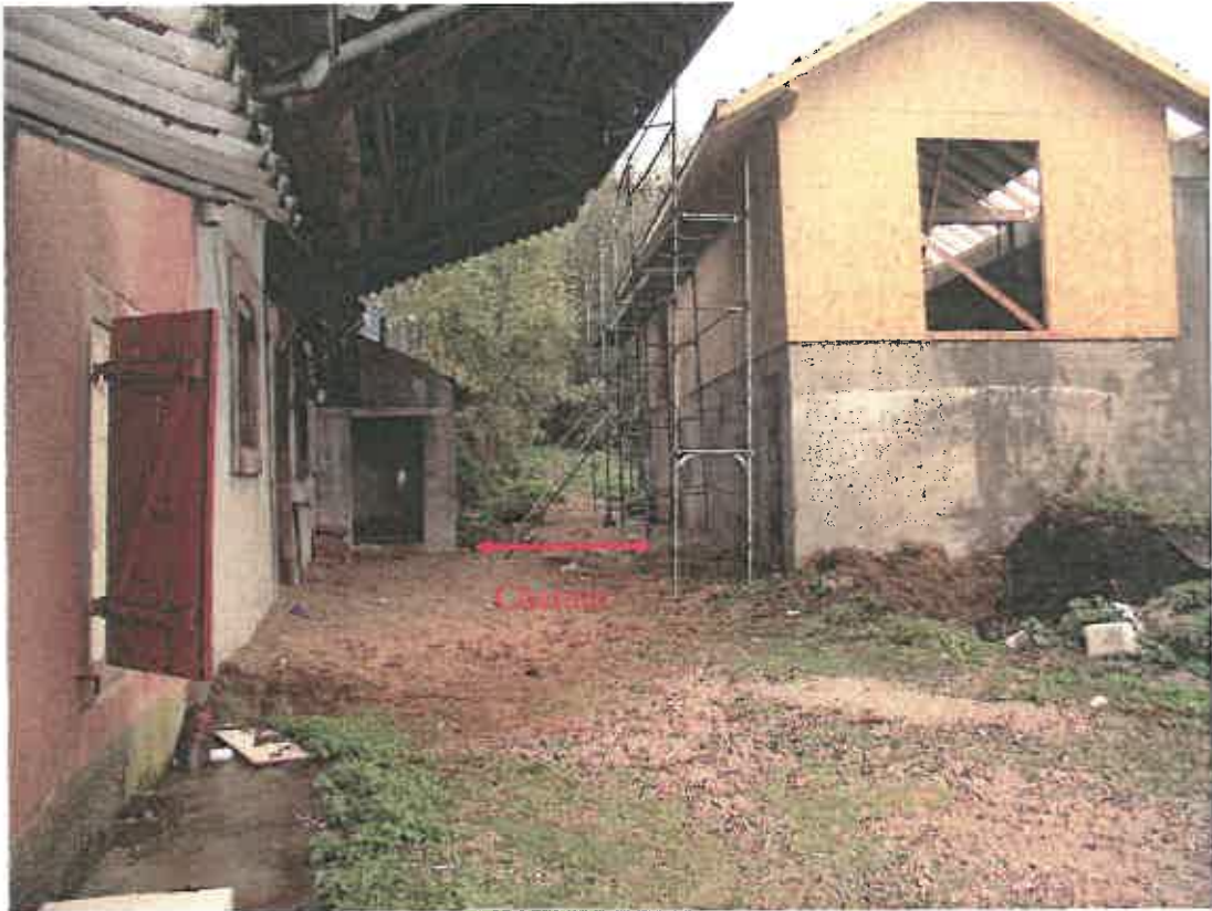
1 – Ex-propriété Boillod, 2 rue des Perches Le chemin passe entre les deux bâtiments et se prolonge entre les arbres
