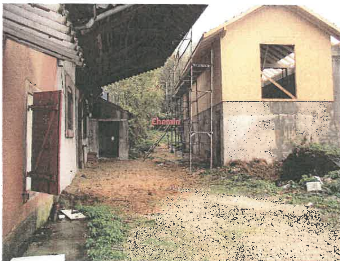
Photos datant de 2003 – les bâtiments sont aujourd'hui démolis et l'état du chemin a empiré
