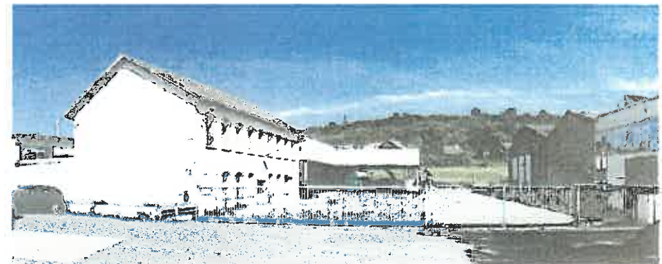
L'accès principal aux installations industrielles, avec la colline de la Miotte à l'arrière-plan.
