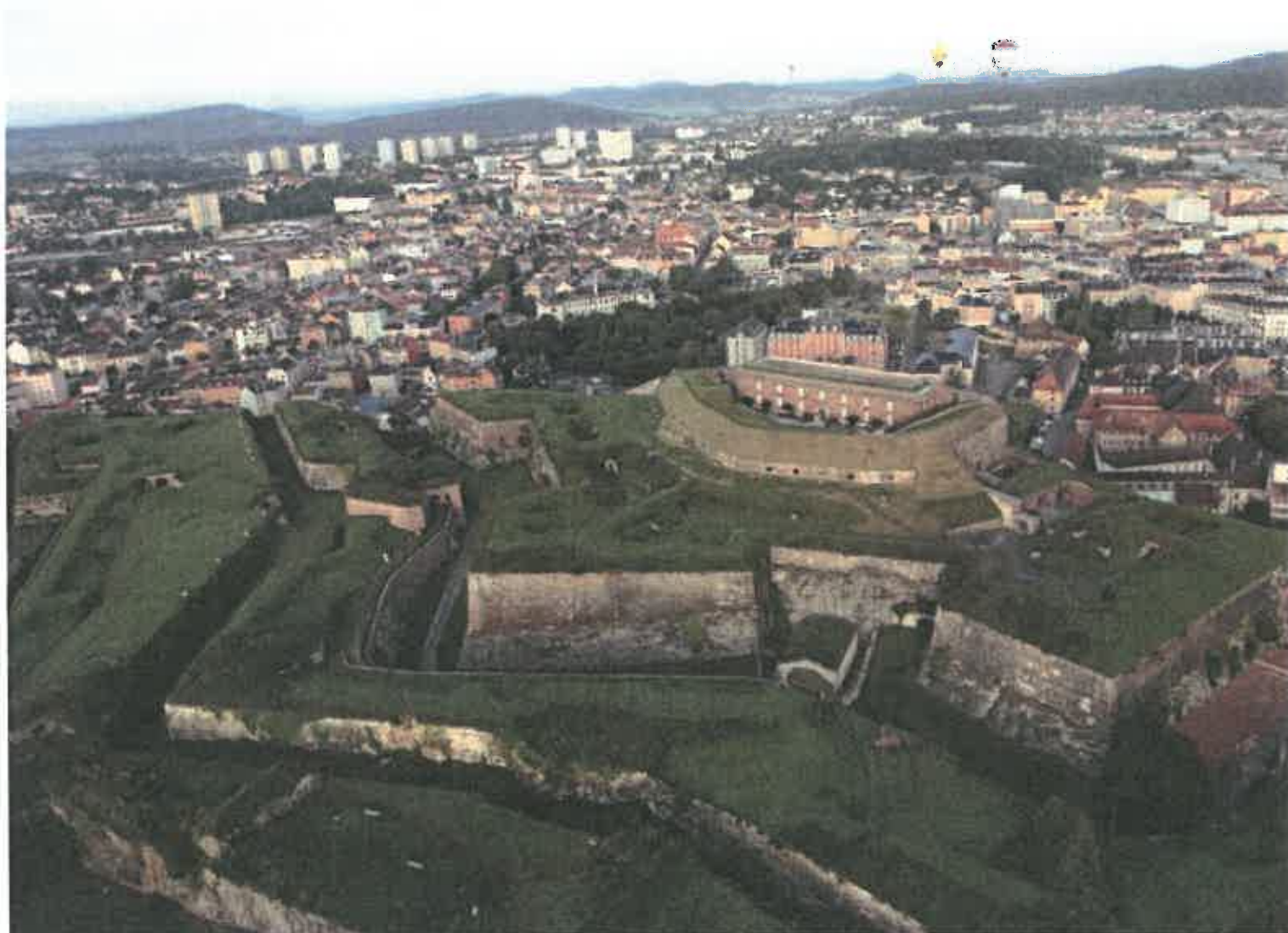
Vue aérienne de la Citadelle
