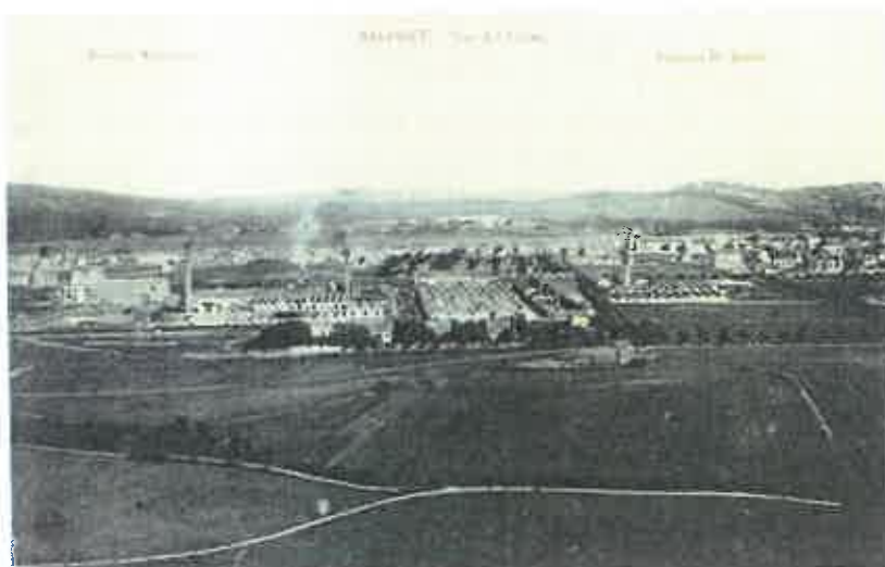
Photographie du site industriel au nord-ouest de Belfort (SACM, DMC)
