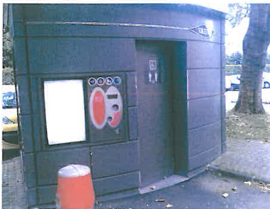
Type HYDRA (arrière théâtre) (bloc autonome, partiellement accessible aux PMR et déjà équipé d'une alarme anti squat)
