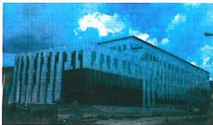
TECHN'HOM bâtiment 328 – Chantier du bâtiment ALSTOM POWER CENTRALE (août 2010)
