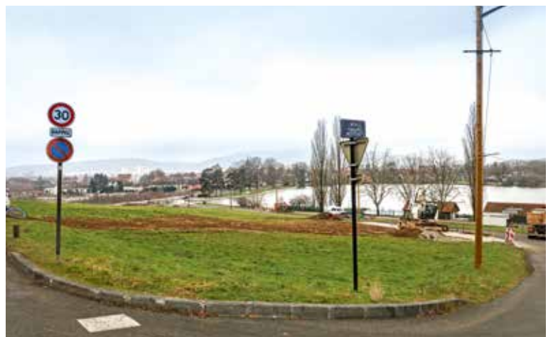
Les premiers travaux en cours pour l'aménagement du futur caniparc
