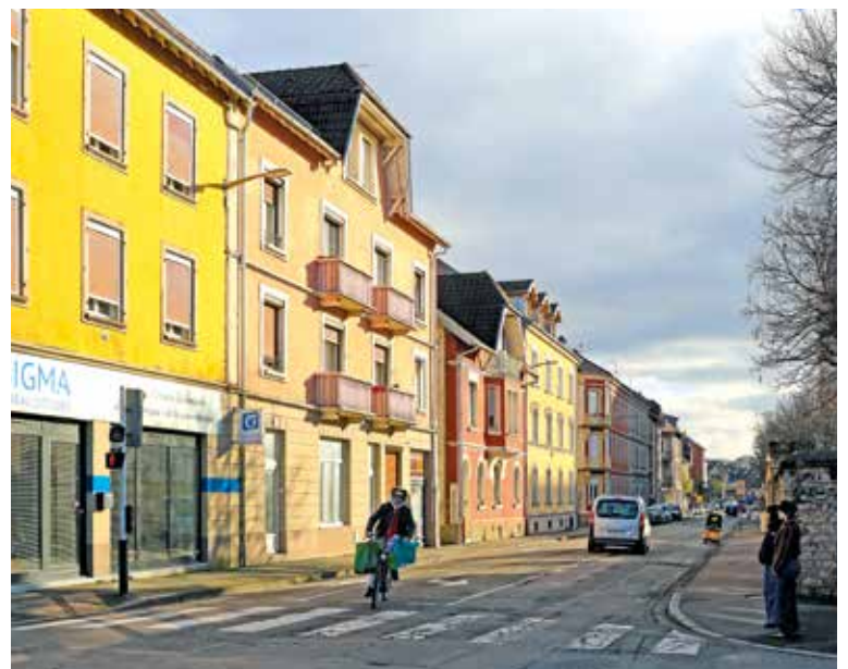
21 immeubles sont concernés par la campagne de ravalement rue François-Voltaire
