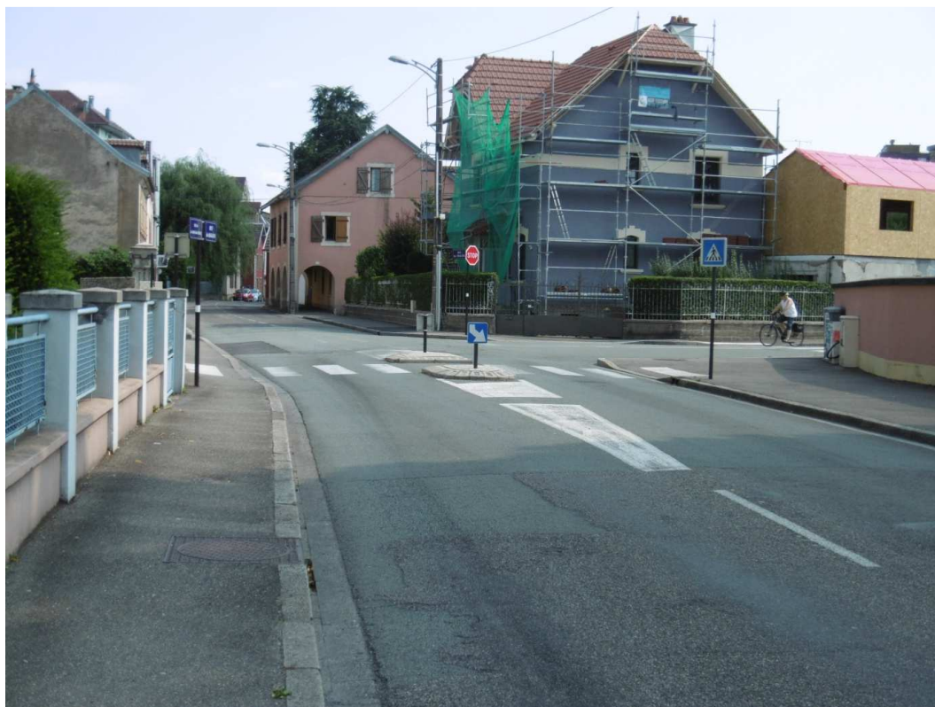
Travaux réalisés rue du magasin
