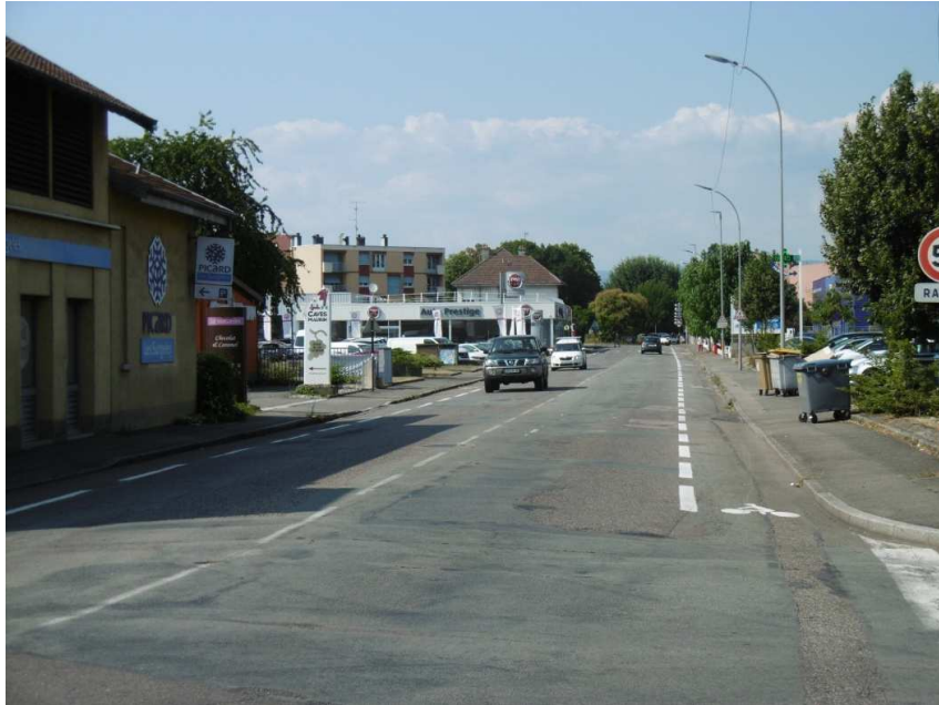
Travaux réalisés Boulevard Henri Dunant
