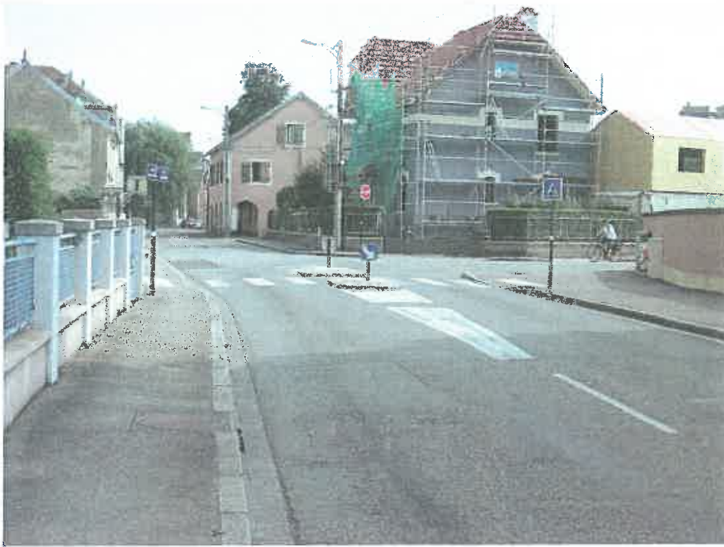
Travaux réalisés rue du magasin
