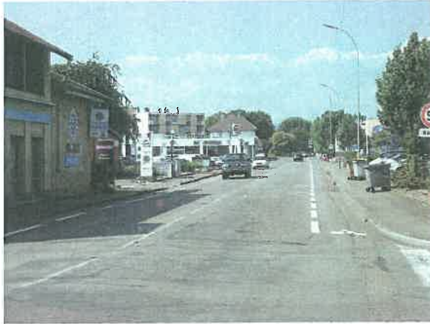
Travaux réalisés Boulevard Henri Dunant
