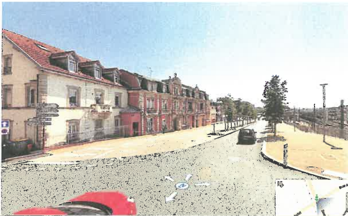
Nouveaux aménagements rue du Pont Neuf
