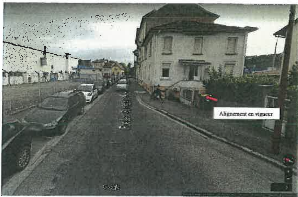
Aménagement au droit des propriétés sises au 2, 2bis et 4 rue Colbert
