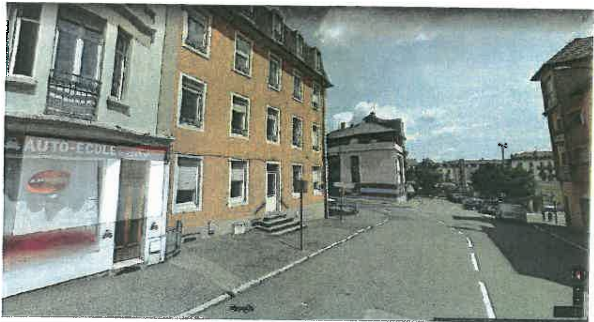
Aménagement au droit du 14 rue Roosevelt
