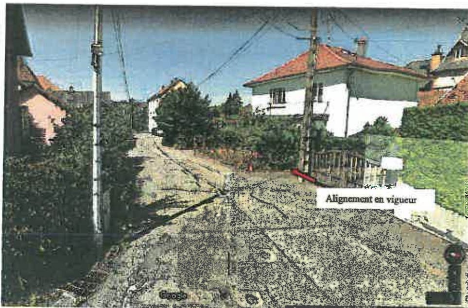
Rétrecissement au droit des 1 et 3 rue de l'Espérance
