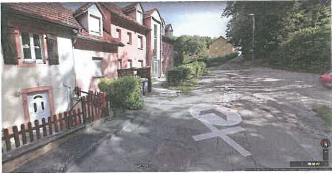
Rue Philippe Grille – Extrémité nord à aménager prochainement
