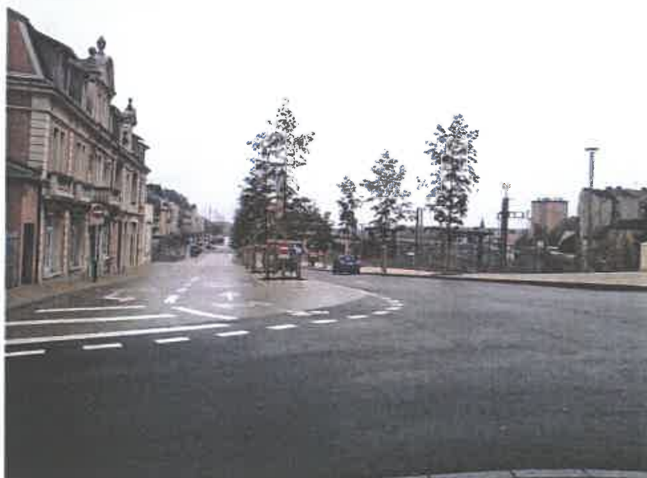
Nouveaux aménagements rue du Pont Neuf
