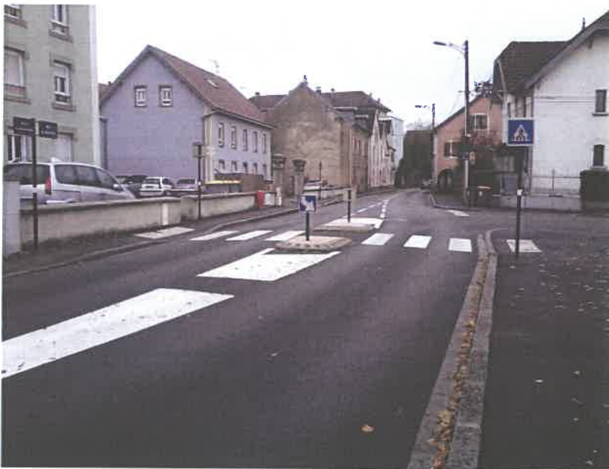
Travaux réalisés rue du magasin
