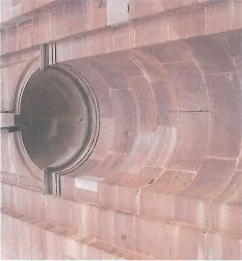
**Le jointoiment au ciment contribue au maintien excessif de l'humidité au niveau des arêtes et à la diffusion des sels dans les pierres**
