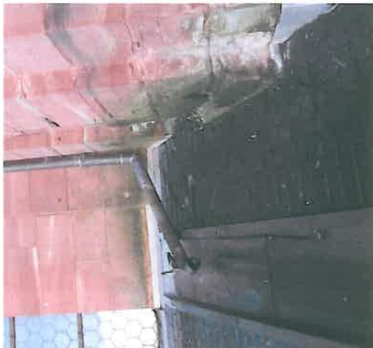
Certaines descentes d'eau ne sont pas reprises dans un système de recueillement des eaux. Les eaux se déversent en pied d'édifice, entraînant une humidité importante au niveau des soubassements, notamment à l'angle nord-est de la tour
