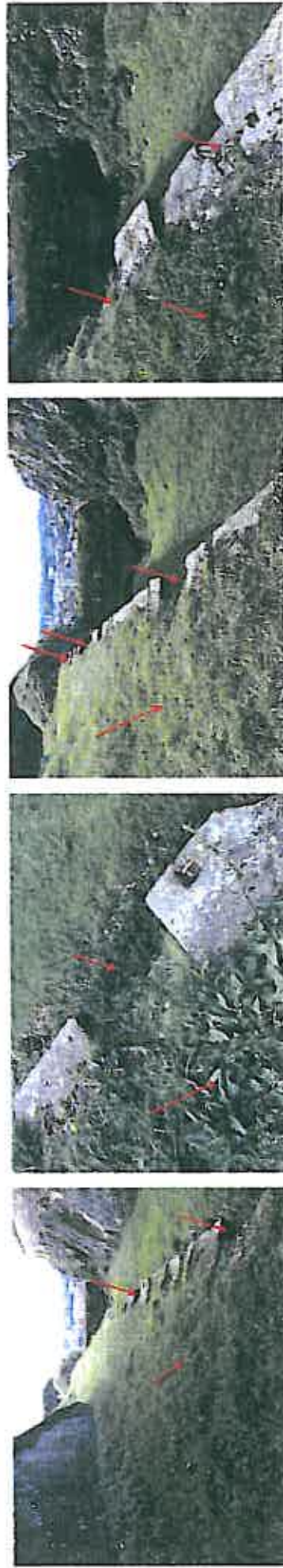
11 à 14. Sur le linéaire du mur de contrescarpe Sud : désorganisation, altération et effilèment important des pierres de couverture, disparition de certaines pierres, joints disparus, présence de végétaux, absence de garde-corps. Absence de profilage du terrain, recouvrement des couvertines par le talutage.
