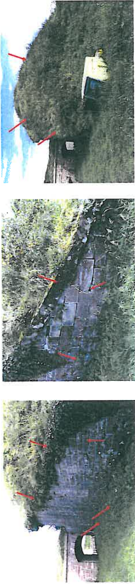
17. Glissement des terres, absence de profilage du tois, développement de la végétation.
