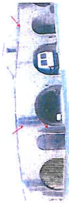
17. Façade Sud du Cavalier Casemate : Altération de l'épiderme des maçonneries : joints ouverts, encrassement des parements, altération de l'arase.
