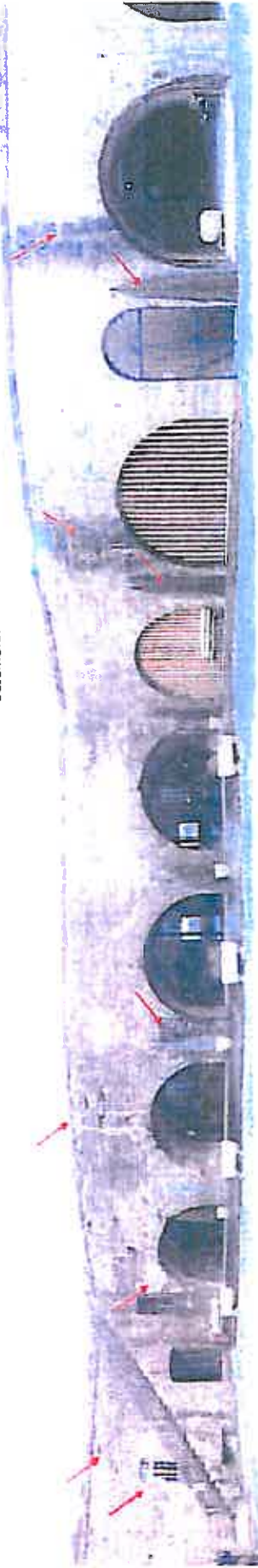
14. Vue d'ensemble du Cavalier casemate côté Cour d'Honneur : altération des parements de la façade, joints ouverts, encrassement, altération de l'arase, encrassement au droit des évacuations d'eau pluviale et traces de réparations extérieures
