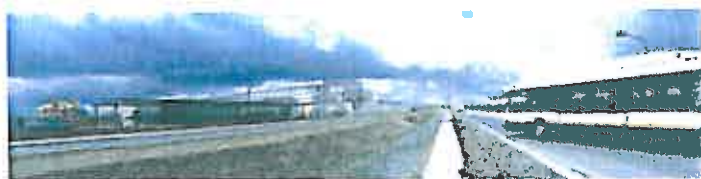
Visite du site d'injection de biométhane dans le réseau gaz naturel de Lille Métropole
