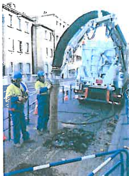
Utilisation d'un camion-aspirateur
