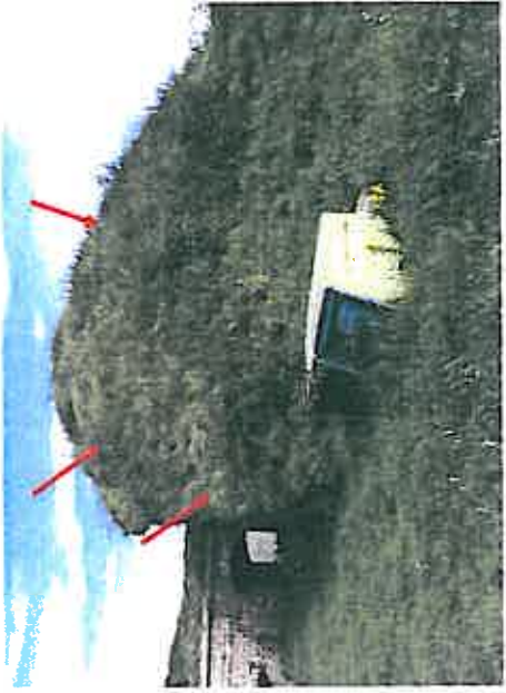
17. Glissement des terres, absence de profilage du tois, développement de la végétation.
