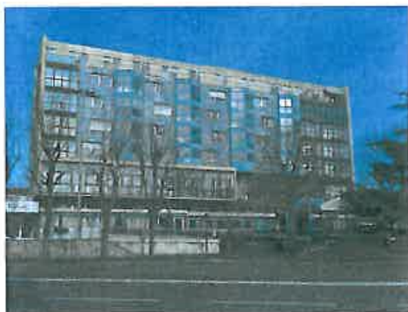
1. Façade principale (Sud)
