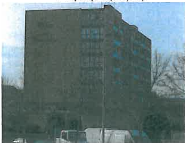
3. Façade arrière (Nord)
