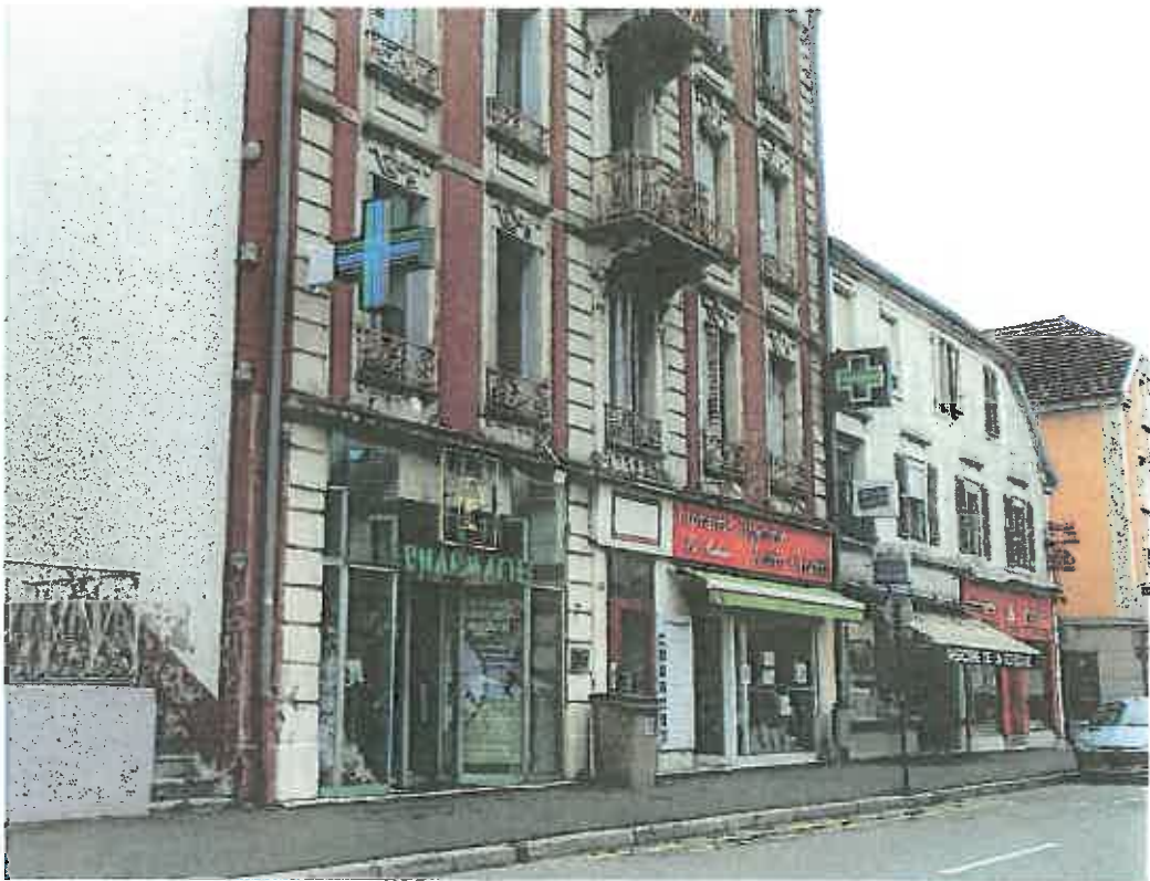
Enseignes positionnées trop en hauteur et répétitives
